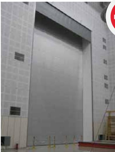
**In dem Labor „ KONCAR POWER TRANSFORMERS“** wo die mittlere Spannung der Transformatoren getestet werden haben wir das elastische rollbare Tor der Serie AK mit der Funktion der elektromagnetischen Abschirmung eingebaut.
